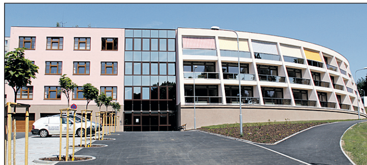
V nově vybudovaném Městském domově pro seniory v Domažlicích bude také moderní rehabilitační oddělení společnosti Reha – Arnika MUDr. Zdeňka Šose.
